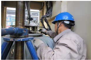
图 9 现场变压器吊芯检修图
